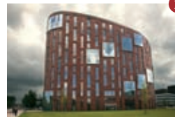
Jeanne Dekkers architecten OZW-gebouw, opgeleverd 2006
